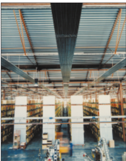
Панели Sunztrip располагаются непосредственно над нужной зоной. Потери на обогрев окружающего пространства и растечки тепла минимальны, что значительно снижает затраты.
