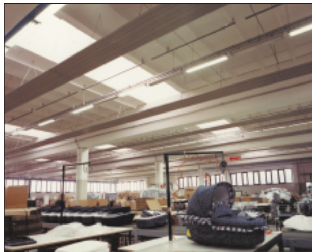
Приборы Sunztrip не содержат вентиляторов или других подвижных частей, поэтому в обогреваемой зоне гарантирована тишина и отсутствие сквозняков.
