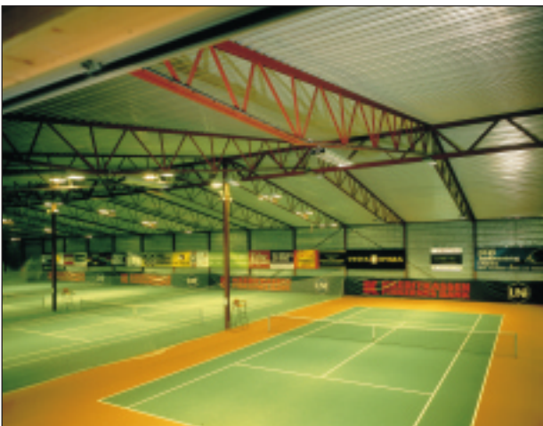
Инфракрасный обогрев дает возможность поддерживать разные температуры в смежных частях одного помещения. Защитные решетки IRG пригодятся там, где нужно предохранять приборы от повреждений, например в спортивных залах.
