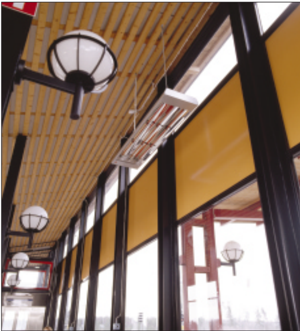
Эта станция в пригороде Стокгольма обогревается приборами IR. Таймерное управление позволяет оптимизировать график обогрева.
