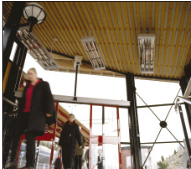
Эта станция в пригороде Стокгольма обогревается приборами IR. Таймерное управление позволяет оптимизировать график обогрева.
