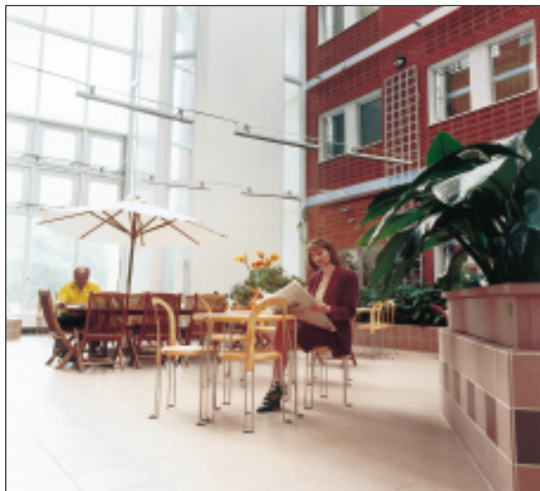
Дополнительный обогрев холла и зимнего сада при помощи приборов Comfortinfra CIR
