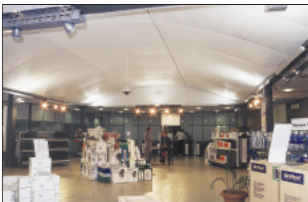
Даже при установке на складе столь большого размера Термоплюс успешно решают задачу общего обогрева помещения.
