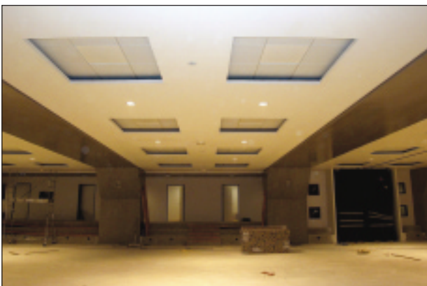
Приборы неплохо вписываются и в восточный стиль. На этом снимке они обогревают зал фехтования на мечах дзюдо-центра в Париже.
