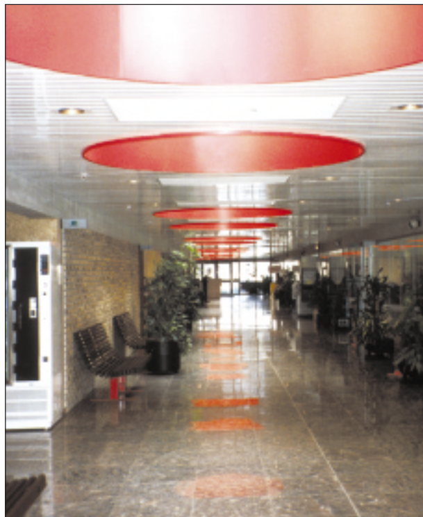
Кассеты НР обеспечивают мягкий обогрев без движения воздуха. Прямоугольные белые кассеты хорошо вписались в яркое архитектурное решение потолка.
