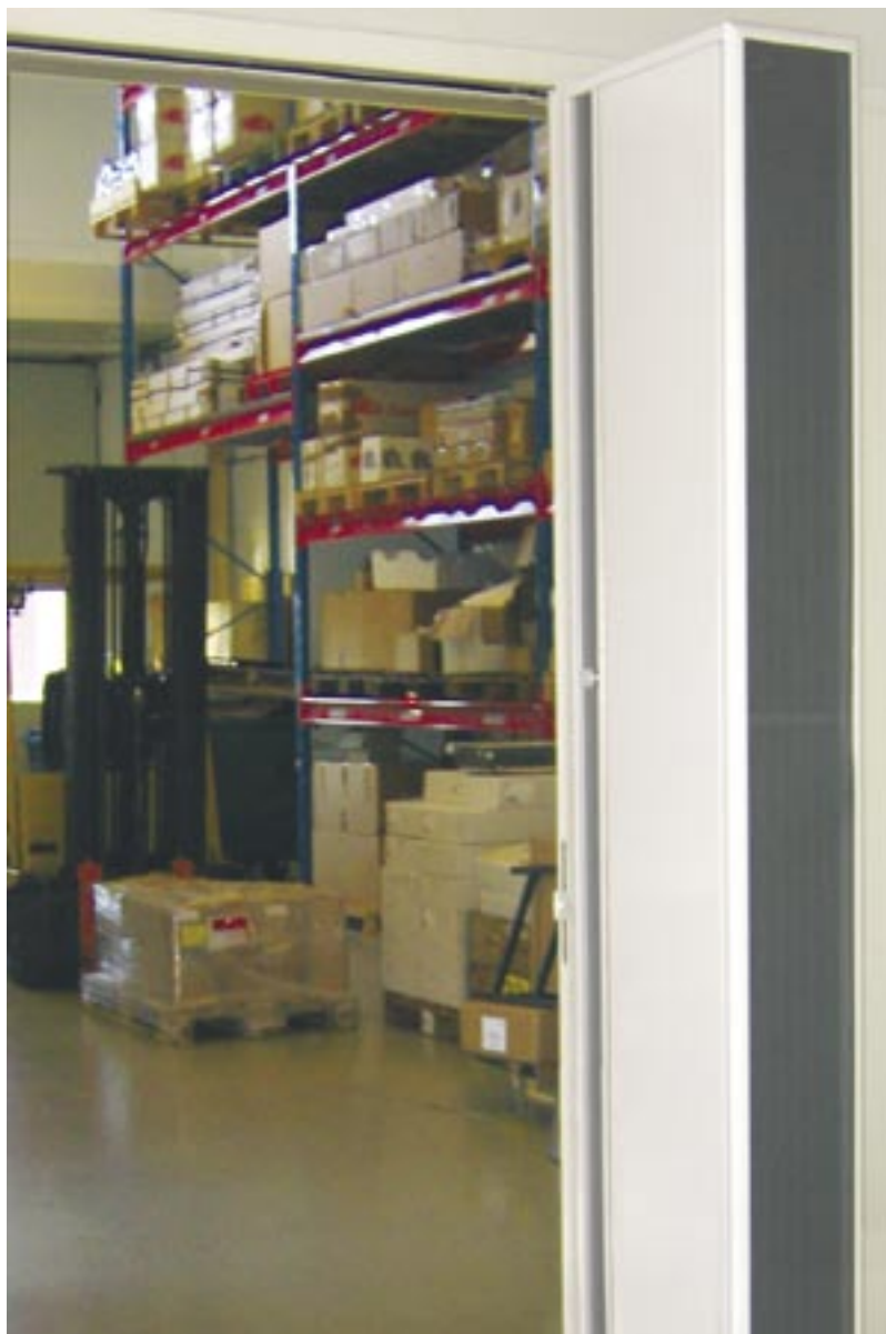
Завеса AGV 4000 в складском помещении, Швеция
