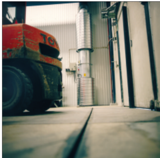
Завеса Thermozone AC600 обеспечивает надежную защиту на пути холодного воздуха в нижней части ворот, потери тепла минимальны и условия работы персонала предприятий значительно улучшаются.
