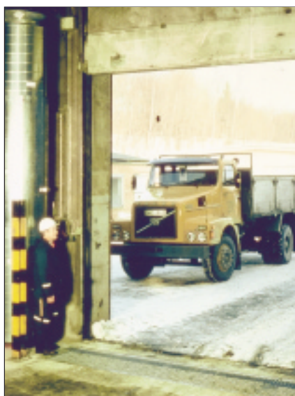
Мощный импульс воздушного потока в нижней части ворот обеспечивает почти 100% его защиту
