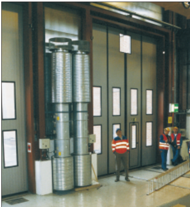
Колонна может располагаться с любой стороны проема. Для ворот большой ширины монтируются две колонны. В этом случае они могут размещаться как с одной, так и с обеих сторон воротного проема.
